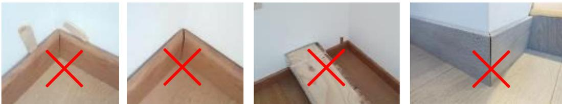
⇒ 您需要钉子或重物之类的物品，以在安装过程中将踢脚板正确固定到位；安装后，踢脚板不能地很好地贴在墙上，安装后，外角是敞开的，…
